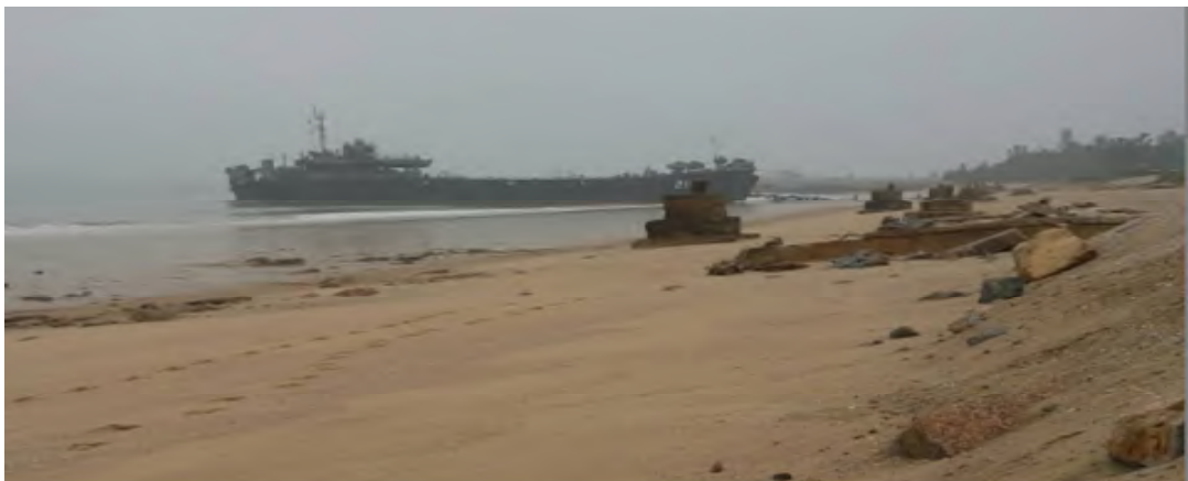
圖 4 海軍登陸艇運補繫攬樁因海砂流失造成繫攬樁底部外露及路燈底座崩塌圖
